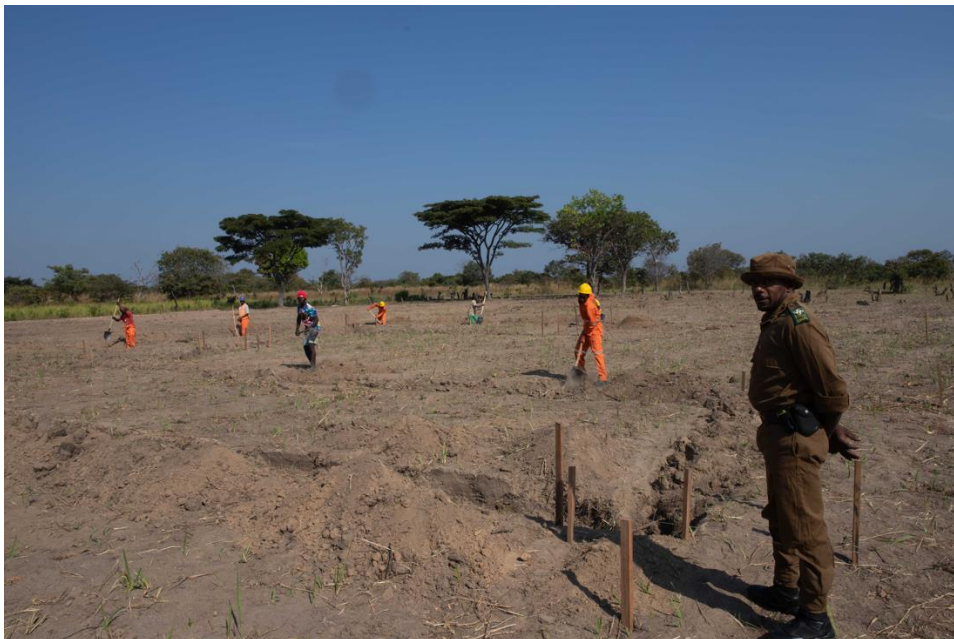
Figura 18. Acompanhamento das obras para construção de uma base em Capunda
